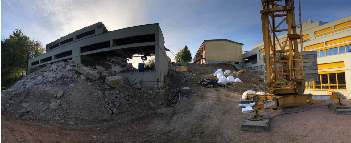
Bauarbeiten Stand: 10/2021 (Quelle: Stadtbauamt Bad Neustadt a. d. Saale)
