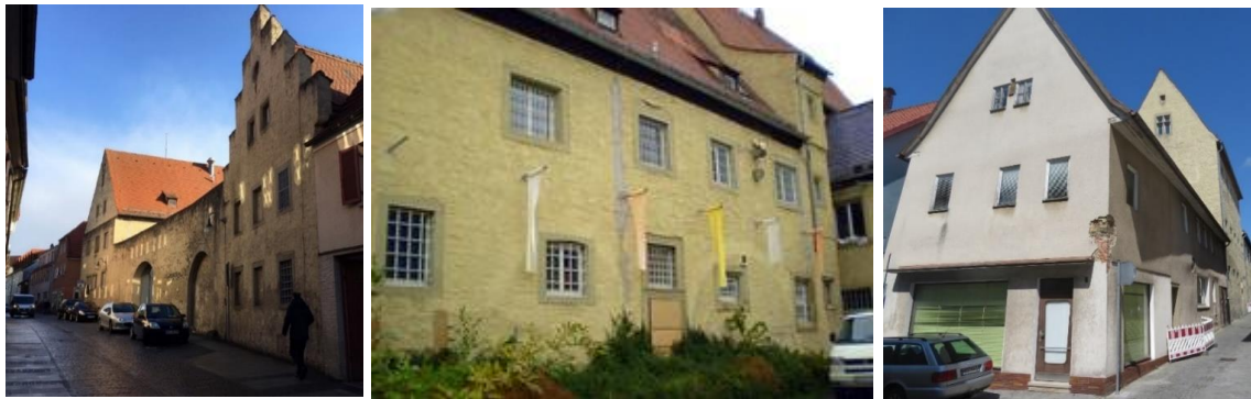
Bestandsbilder Alte Amtskellerei und Storchengasse 8 (Quelle: Stadtbauamt Bad Neustadt a. d. Saale)
