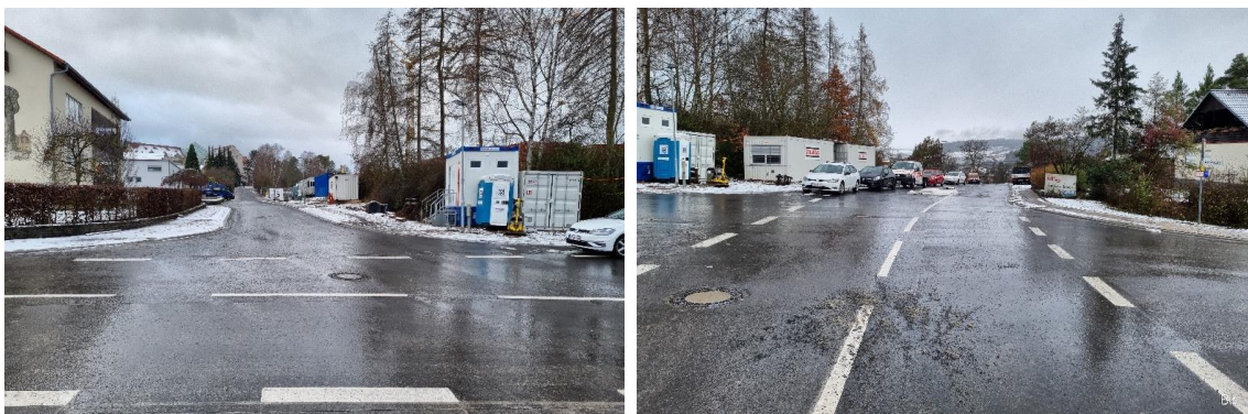
Baustellenbild (Stand: KW49/2021) (Quelle: Stadtbauamt Bad Neustadt a. d. Saale)
