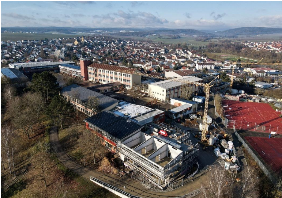
Luftbild der Baustelle (Stand: KW50/2021) (Quelle: Bastian Steinbach)
