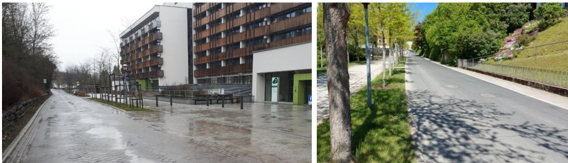
Vor der Sanierung vs. nach der Sanierung (Quelle: Stadtbauamt Bad Neustadt a. d. Saale)
