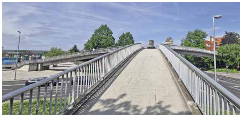
Bestandsbilder Falaiser Brücke
