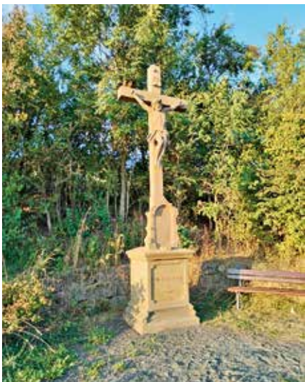
Saniertes Steinkreuz Foto: Stadtbauamt Bad Neustadt a. d. Saale
