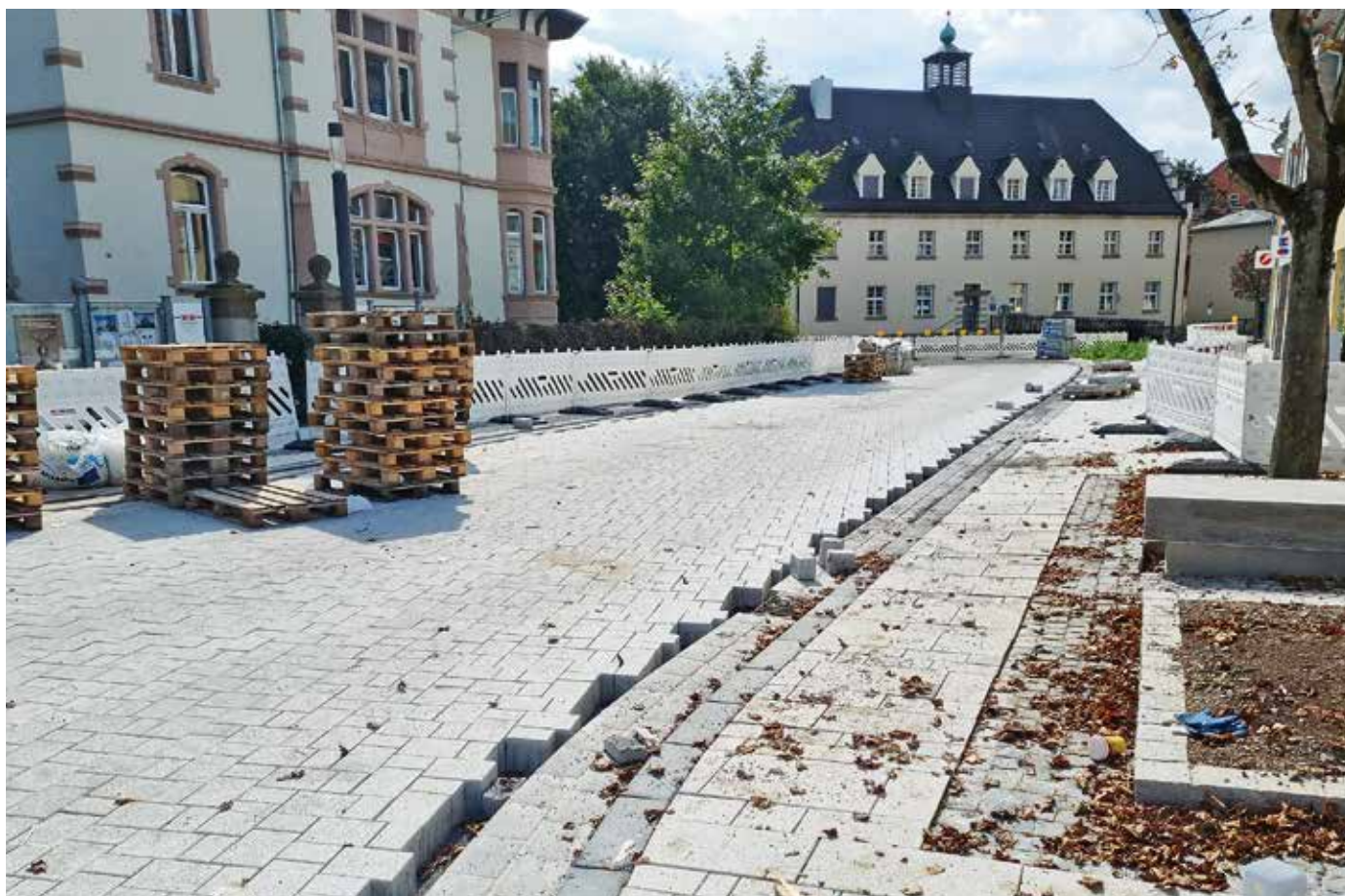
Foto: Otto-Hahn-Straße mit neuem Plattenbelag
