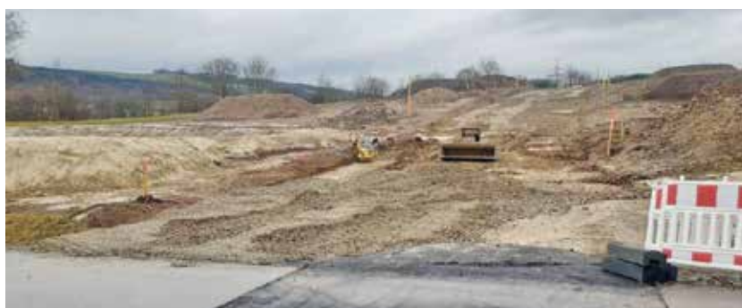
Baugebiet „Helfert“ aktueller Baustand Quelle: Stadtbauamt Bad Neustadt a. d. Saale
