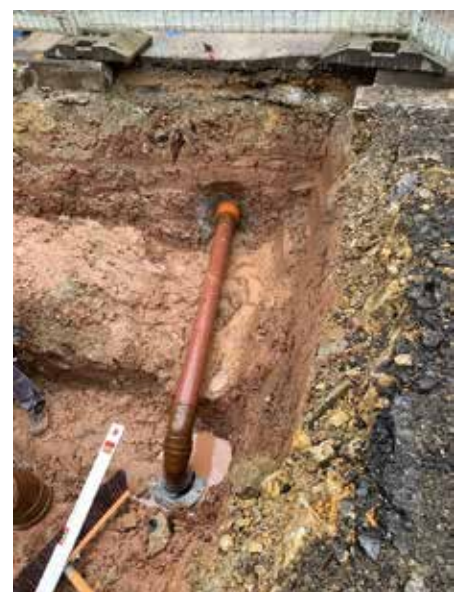
Kanal-Hausanschluss. Foto: Stadtbauamt
