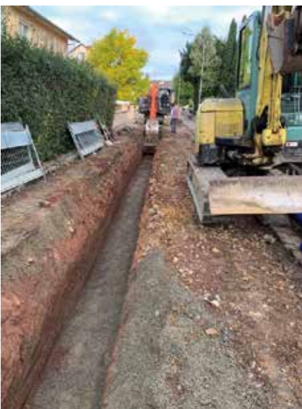
Wasserleitungsverlegung. Foto: Stadtbauamt
