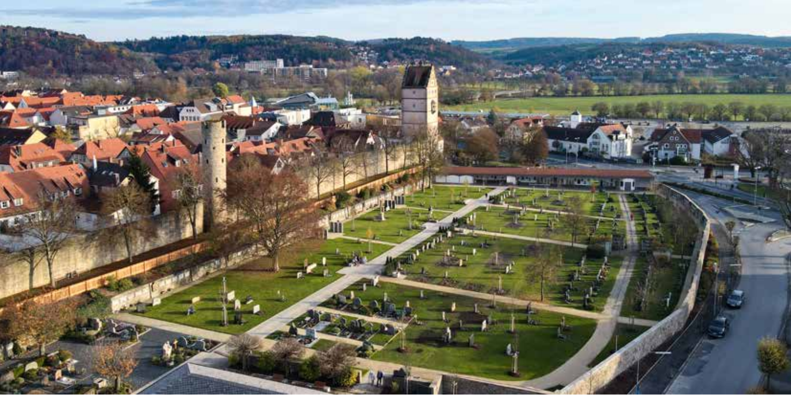
Luftbild nach Sanierung. Foto: Bastian Steinbach
