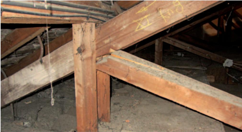
Defizite und Risse in der Dachkonstruktion / Giebelmauerwerk
