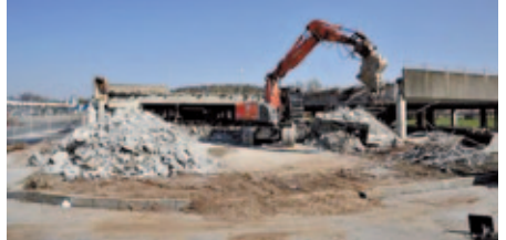
Parkplatz „Am Zent“ während der Baumaßnahme Foto: Flechsig, Juli 2011
