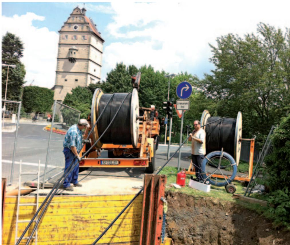
bringenden Kabel dient. In der gesamten Maßnahme wurden zwischen Festplatz und Hohntor abschnittsweise bis zu 11 Leerrohre verbaut, die Kabelsysteme für die Mittelspannung, Niederspannung, Straßenbeleuchtung sowie Steuerungs- und Kommunikationstechnik aufnehmen.
