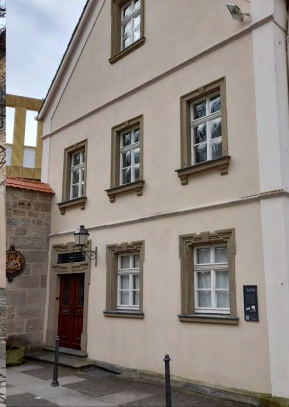
Altes Amtshaus in der Hohnstraße
